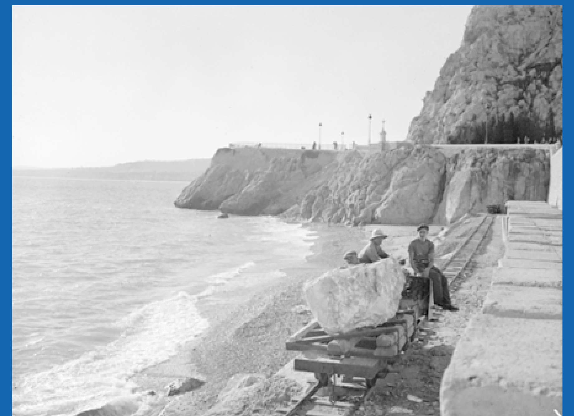
Restauration de la jetée au droit du quai Infernet côté extérieur ; rechargement en blocs naturels ; vue du début de la jetée et de Rauba Capeu ; au premier plan, les rails installés pour véhiculer les blocs, et la plage., 1941
